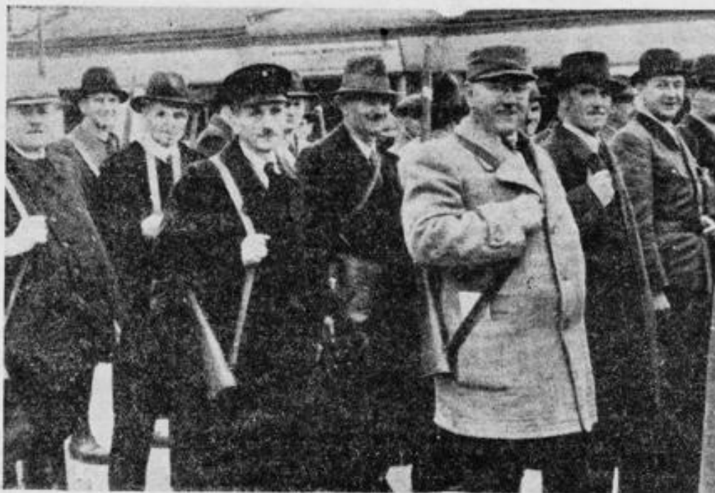
Alle Altersklassen sind zum Volkssturm geeilt
