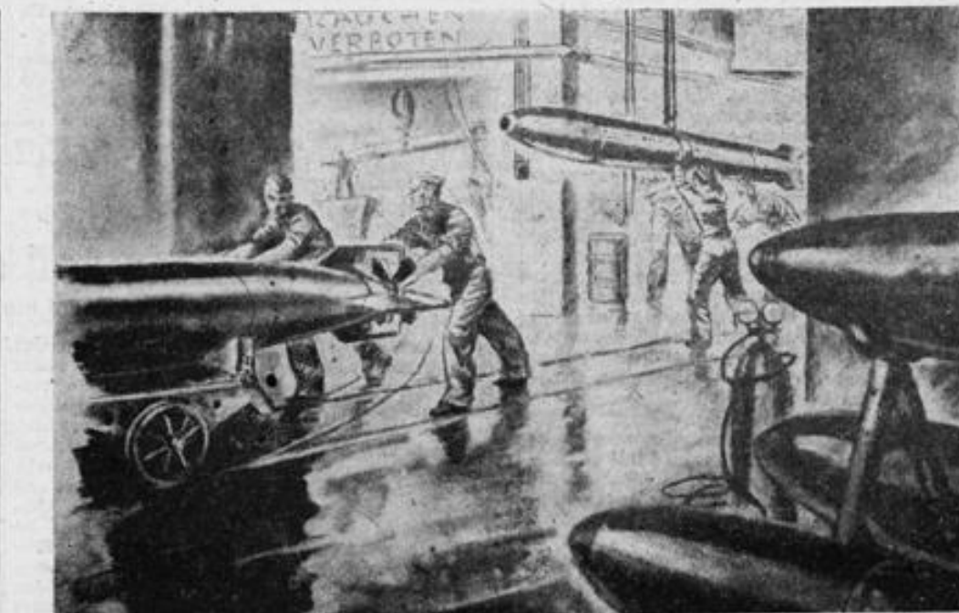
Torpedoraum im Bunker
