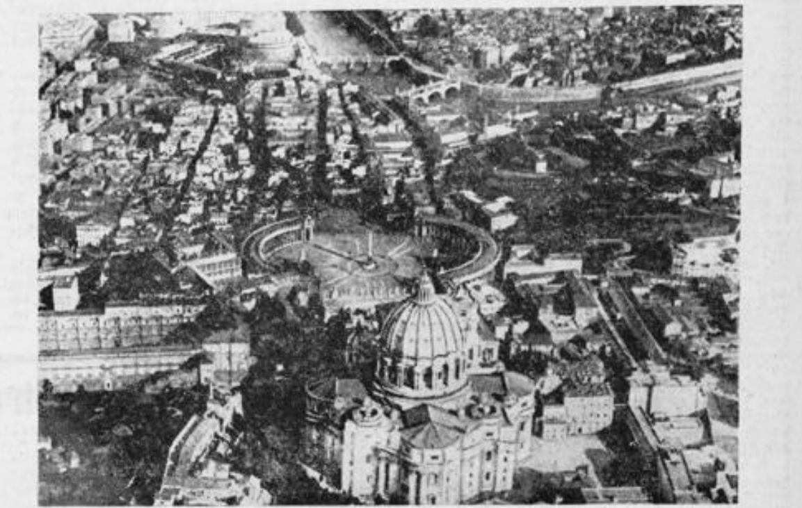
Weltbild-Auslandsfoto Der ruchlose Bombenüberfall der Anglo-Amerikaner auf die Vatikanstadt Bei dem ruchlosen Überfall der anglo-amerikanischen Luftpiraten auf die Vatikanstadt erlitten unersetzliche Kunstwerke schwere Beschädigungen. Die Schäden an der Peterskirche, die besonders umfangreich sind, haben zur vorübergehenden Schließung der Kirche geführt. Unser Bild: Blick auf die Vatikanstadt
