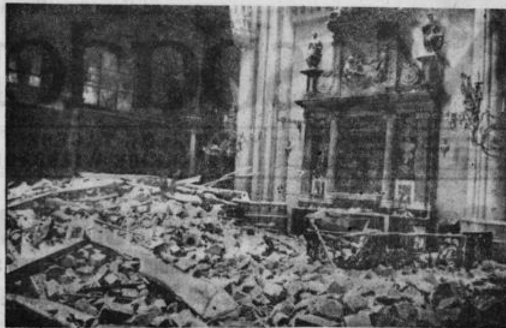
Die Zerstörungen im Kölner Dom Dreikönigsaltar mit der schwarzen Mutter Gottes, die allabendlich in Sicherheit gebracht wird und deshalb verschont geblieben ist
