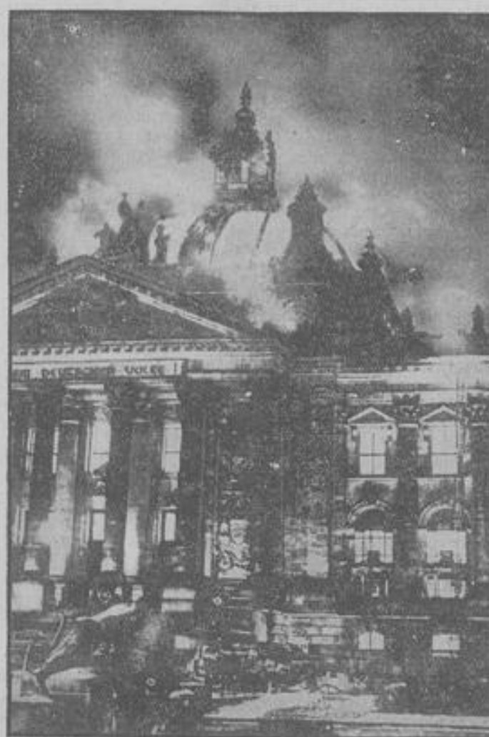
Das brennende Reichstagsgebäude
