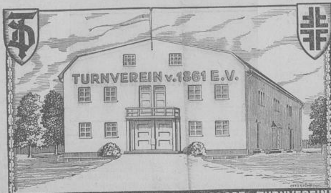
TURNVEREIN v. 1861 E. V. TURNHALLE DES TURNVEREIN v. 1861 E. V., FLÖRSHEIM a. M., ERBAUT 1930/31, über 600 qm groß ca. 1200 Pers. fassend
