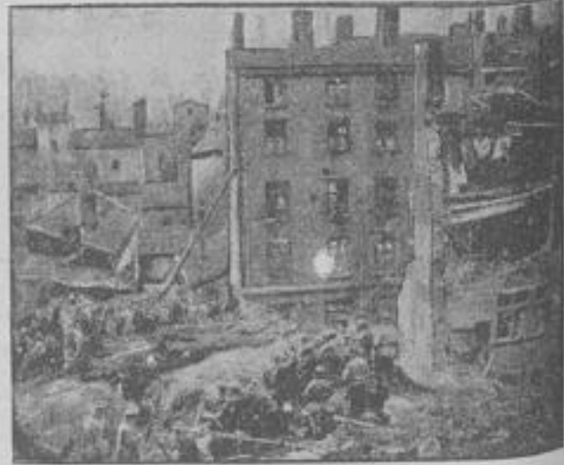
Aufräumungsarbeiten in Lyon.
