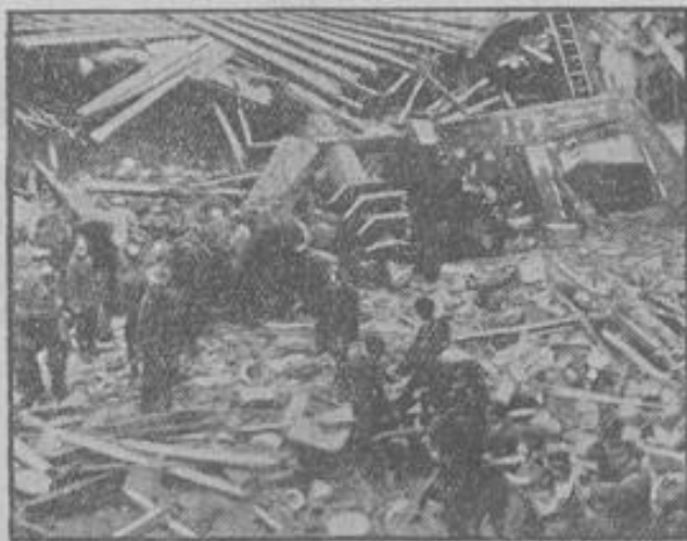
An der Trümmerstätte in Essen, wo durch eine Explosionskatastrophe ein Haus zerstört wurde.
