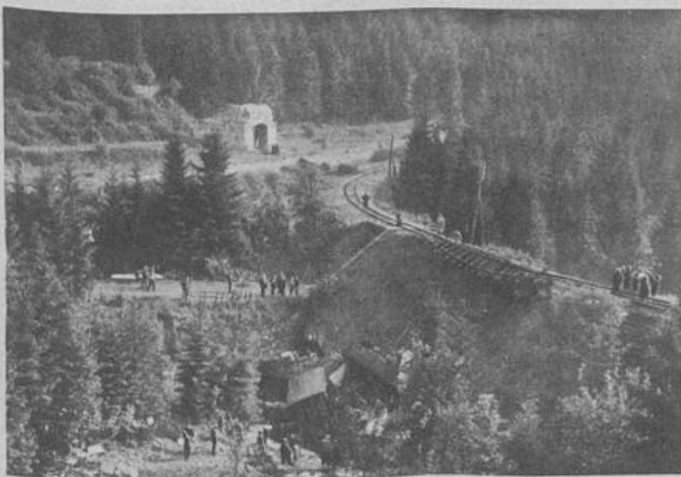
Das Eisenbahnunglück im Harz, unweit von Hasserode, am 6. Juli, herbeigeführt durch ein Unwetter, das den Damm zerstörte. Die Zahl der Getöteten beträgt 9, die der Verletzten 22. [H. Wesner]
