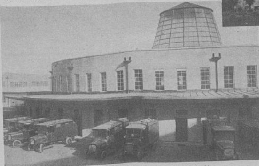
Das modernste Paketpostamt der Welt ist in München entstanden. Die Abbildung zeigt den Rundbau von der Südseite während des Beladens der Zustellwagen. [Atlantic]
