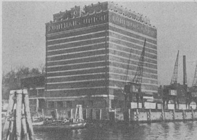
Das neue Kühlhaus in Altona
