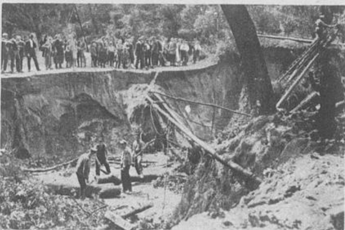
2. Instandsetzungsarbeiten an dem weggespalten Teil der Chaussee von Woltersdorf nach Kaltberge. [Photothek]
