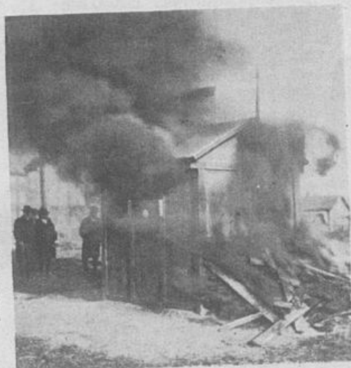
Ein feuersicheres Haus Sensationelle Erfindung eines Hamburger Ingenieurs. Das Haus während des Brandes. [Atlantic]
