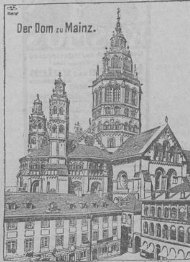
Zur Einsturzgefahr des mittelalterlichen Bauwerkes.
