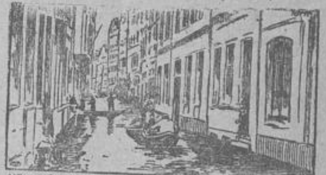
Köln-Mülheim, wo infolge Dammbruchs das Wasser die Straßen überschwemmte.
