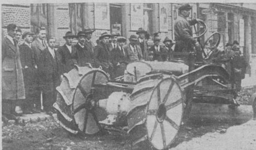
Amerikanische Methoden bei der Straßenarbeit in Wien Eine amerikanische Aufreifmaschine, die bei Straßenarbeiten in Wien in Tätigkeit tritt. [Atlantique]
