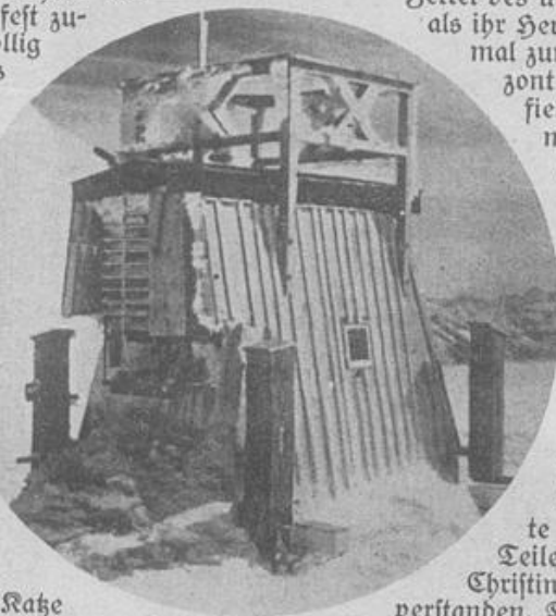
Eine Wetterwarte in 3400 m Höhe, die auf dem Jungfraujoch von der Schweizer meteorologischen Anstalt errichtet wurde. [Wolter]
