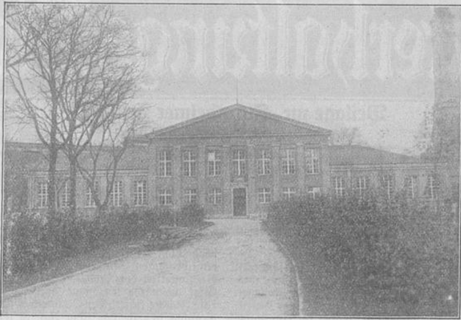
Das neue Rauch-Sinkel-Museum in Berlin in der Hardenbergstraße ist jetzt vollendet worden. [Atlantic.]
