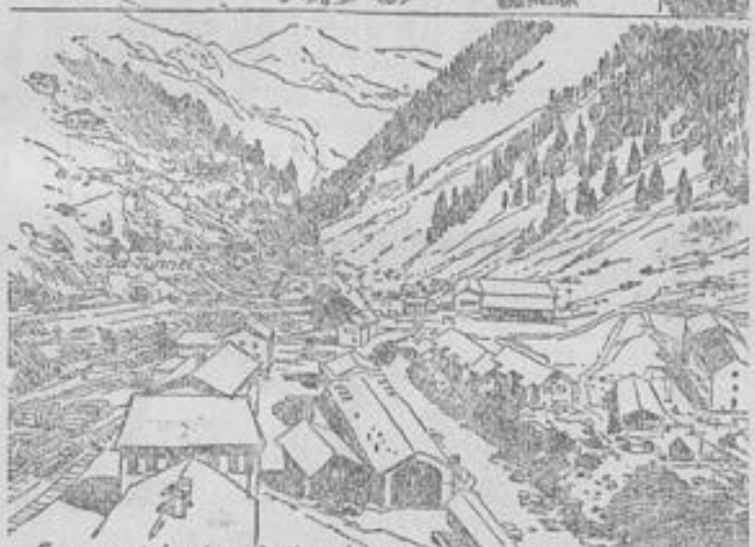
Goppenstein, der südliche Ausgangspunkt d. Tunnels
