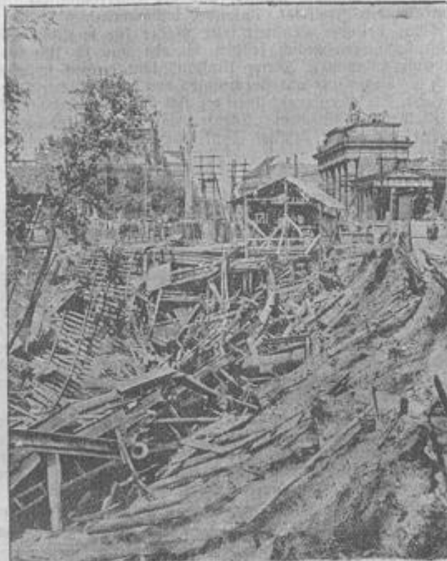
Der eingestürzte Tunnel
