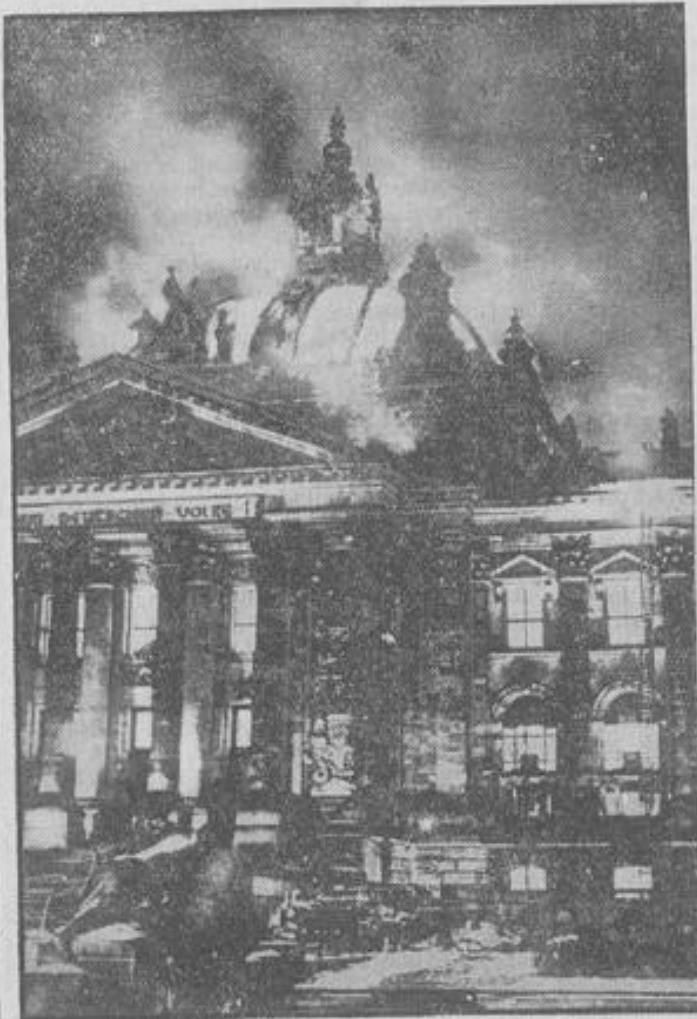
Das brennende Reichstagsgebäude
