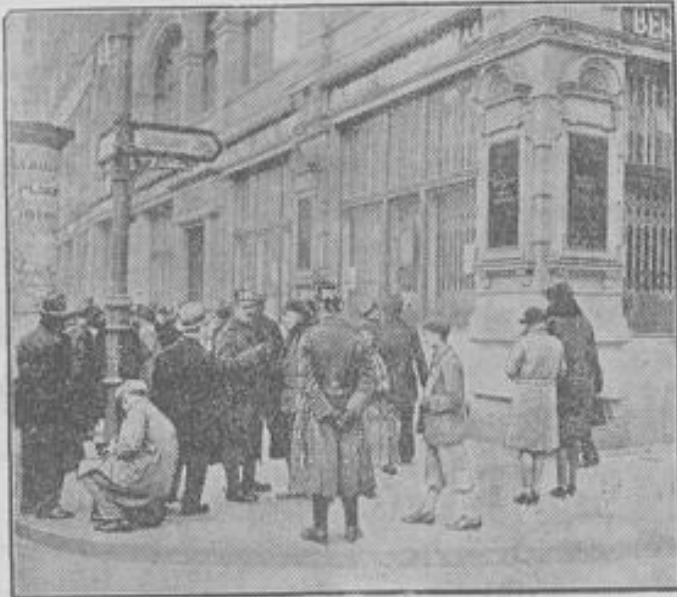
Das Hauptgebäude der zusammengebrochenen Grundbesitz-Bank in Berlin.
