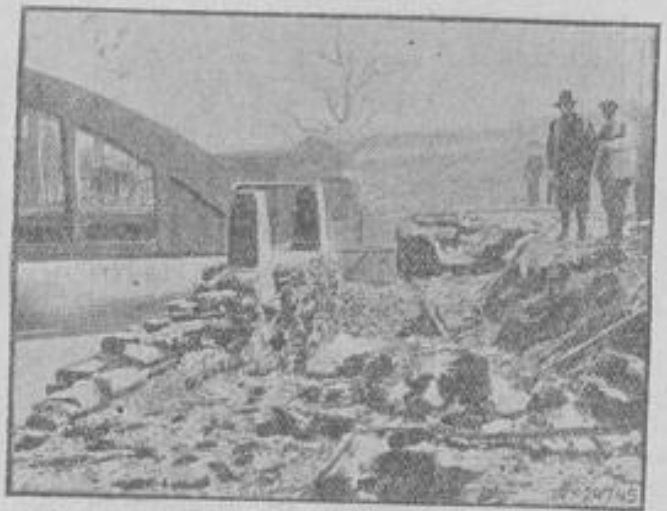
Unwetter über Baden. Unser Bild zeigt das zerstörte Ufer der Doo bei Berghausen in der Nähe von Karlsruhe.
