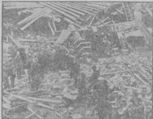
An der Zimmerkammer in Offen, wo durch eine Explosionskatastrophe ein Haus zerstört wurde.
