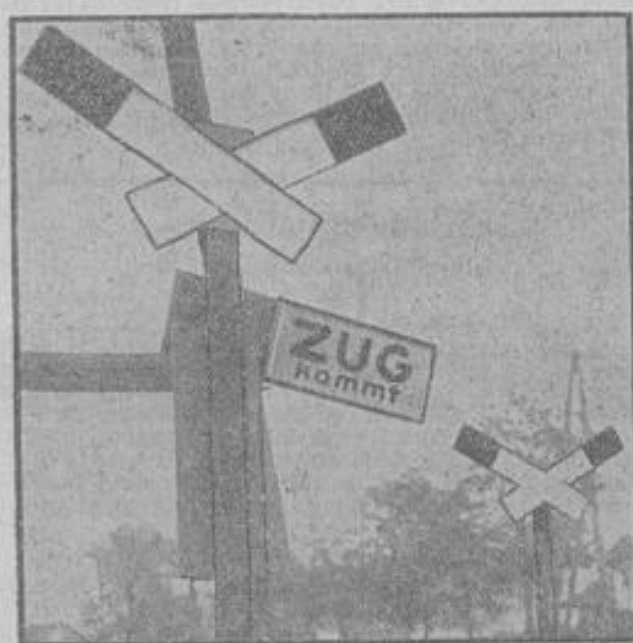
Neue Sicherung von Bahnübergängen.
