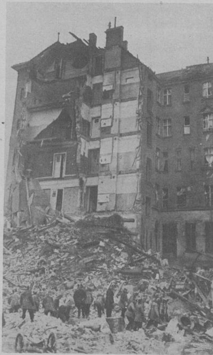
Explosionskatastrophe in der Landsberger Allee, Berlin verursacht durch ein schabhaftes Hauptgasrohr, bei welcher 7 Tote und 17 teils Schwerverletzte bisher geborgen wurden. [D. Pr.-Ph.-B.]
