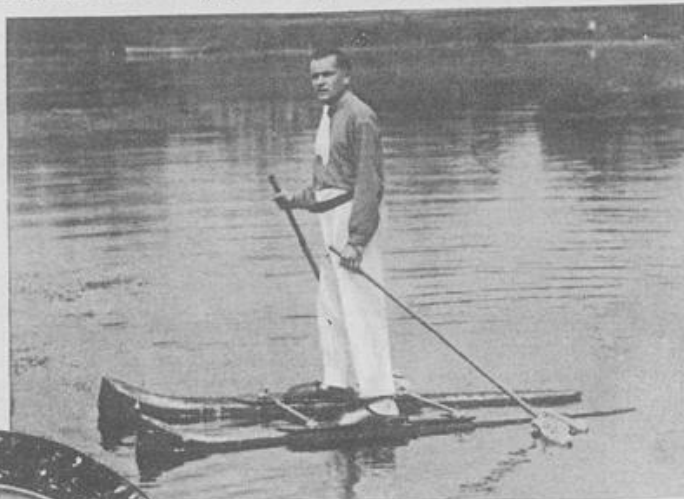
Wieder ein neues Wassersportgerät Der Wassersti, eine Erfindung des Ingenieurs Sauer in Göppingen, der es ermöglicht, ebenso wie mit dem Schneeschuh zu Lande, auf dem Wasser größere Touren zurückzulegen. [Atlantico]
