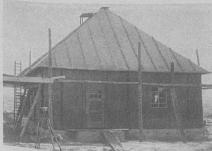
Ein Siedlungshaus aus Stahl in Berlin-Tempelhof
