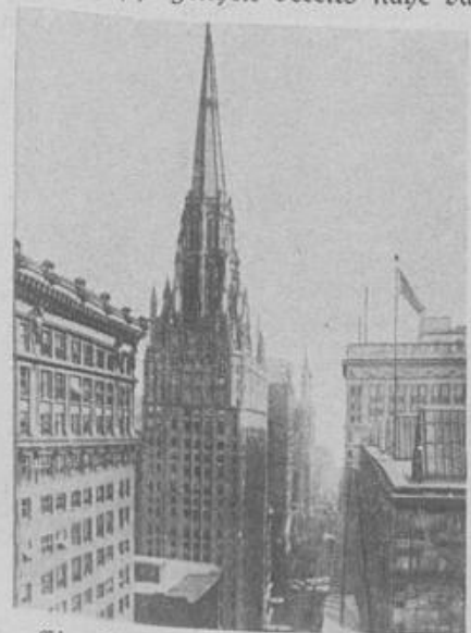
Ein Wollenträger als Kirche Die neue Methodistische Kirche in Chicago, eine Kombination von Kirche und Geschäftshaus. Während in den unteren Räumen Gottesdienste abgehalten werden, spielt sich in den oberen Stockwerken reges Geschäftsleben ab. [Weisse-Photo-Vertrieb]
