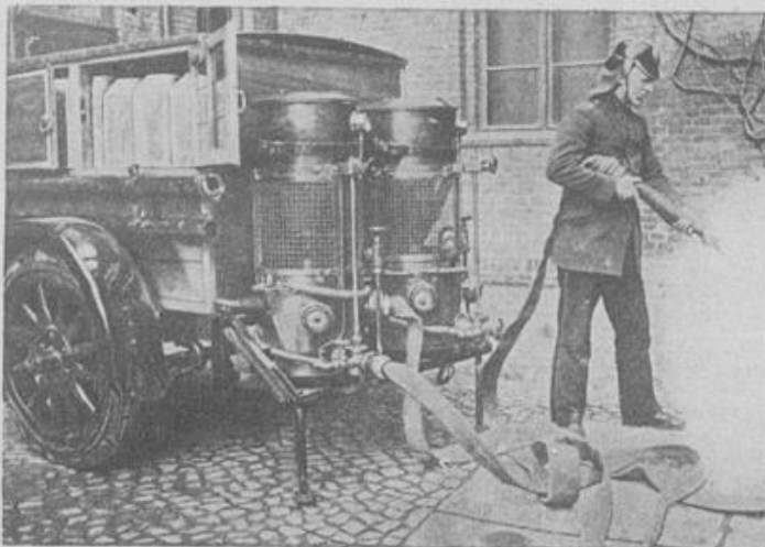
Seifenschaum zum Löschen von Benzin Ein neuer Schaumlöschapparat zur Bekämpfung von brennendem Öl und Benzin wurde von der Berliner Feuerwehr als zweirädriger Anhängewagen in Betrieb genommen. An der Rückseite des Anhängers sind zwei große Schaum-Generatoren angebracht, von denen jeder in einer Minute 8000 Liter Schaum erzeugt. [Atlantia]
