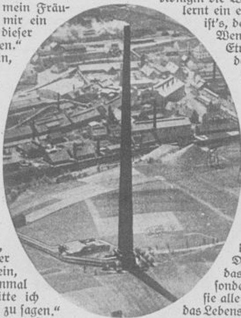
Der höchste Schornstein in Europa büßte der Schornstein in Galsbrücke bei Freiberg in Sachsen sein, der eine Höhe von 140 m hat. [Groß]
