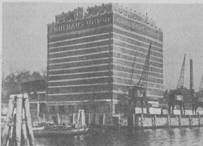
Das neue Kühlhaus in Altona
