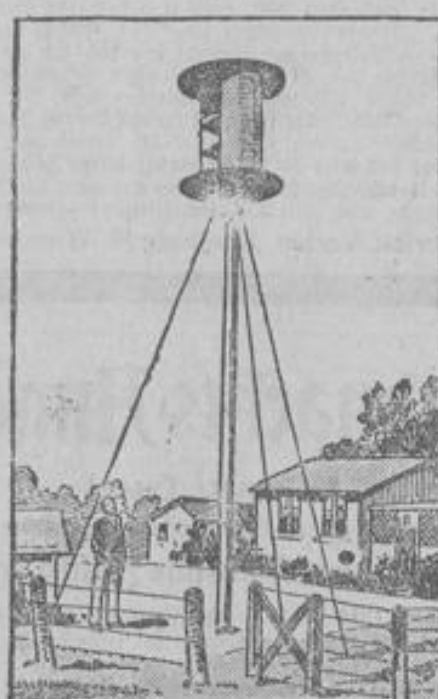
Eine kleiner Rotorpumpe, die in einer Berliner Laubenkolonie aufgestellt ist und täglich 50 000 Liter Wasser fünf Meter hoch befördert.
