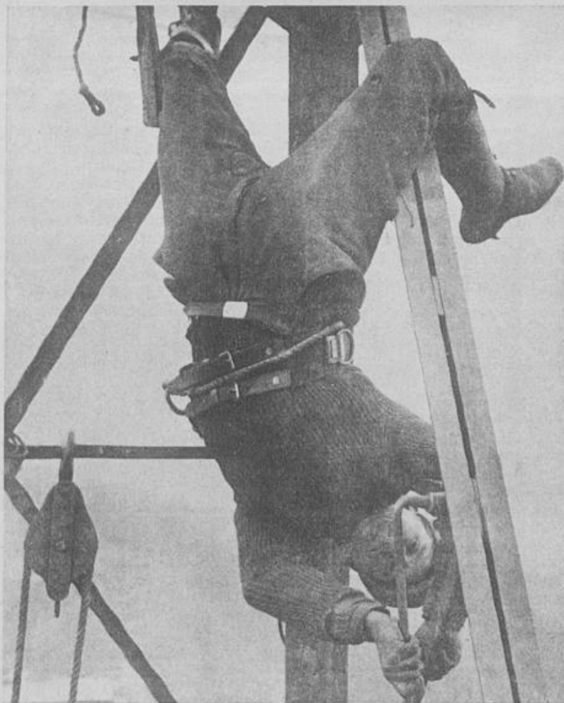
Keine Filmaufnahme — halbschwerer Montagearbeiten in schwindelnder Höhe am östlichen Antennenmast des Rhein-Ruhr-Senders in Langenberg (Rheinl.)
