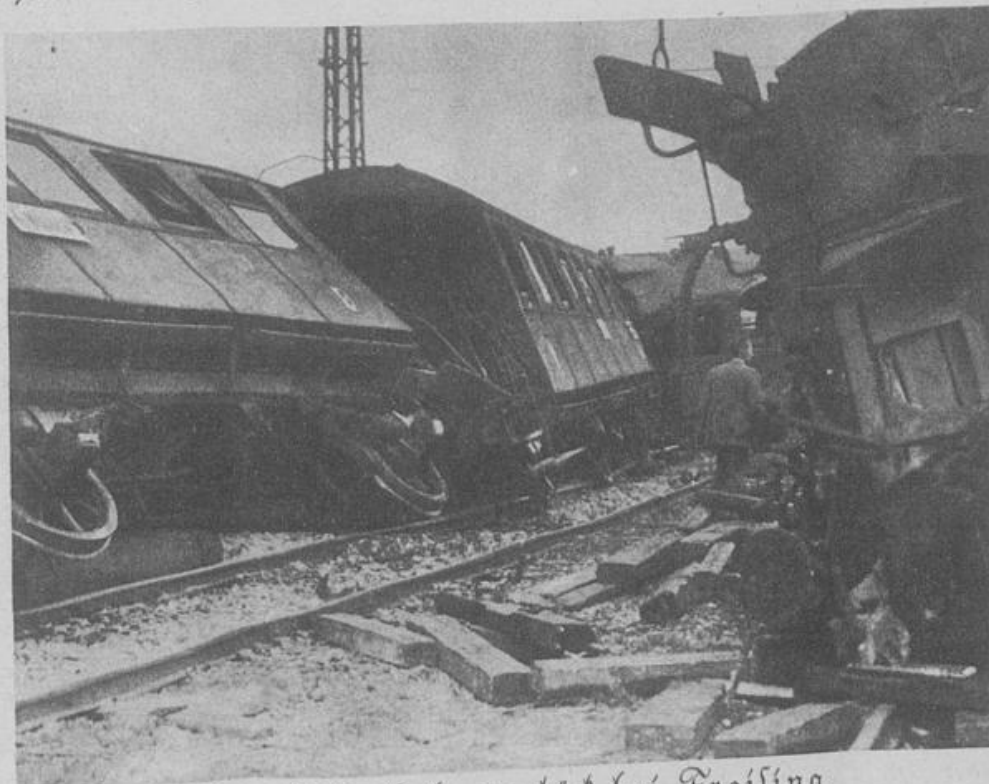
Das Eisenbahnunglück bei Freising
