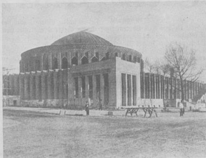
Zur Eröffnung der Gesolei in Düsseldorf Bild auf das im Bau befindliche Planetarium. [Atlantia]
