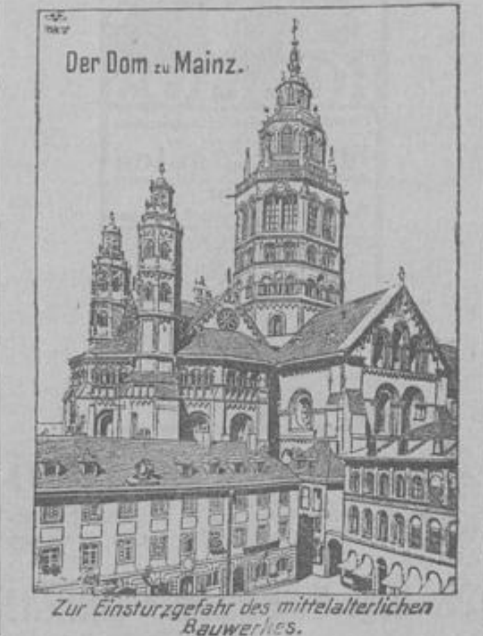
Zur Einsturzgefahr des mittelalterlichen Bauwerkes.
