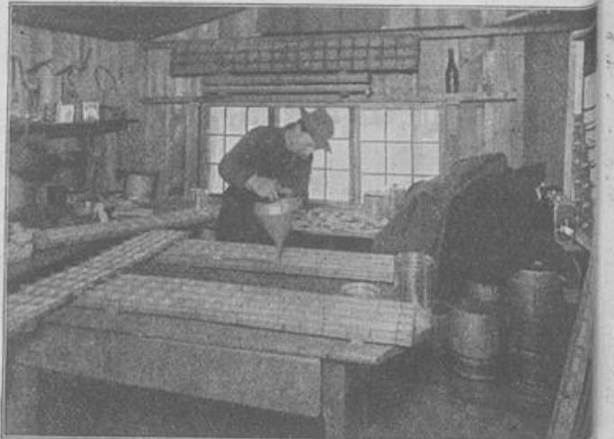
Aus einer im Wald gelegenen Zuckerfabrik in Vermont. Der aus dem Ahornsaft gewonnene Sirup wird in Blechformen nochmals eingedampft und in Zucker verwandelt.
