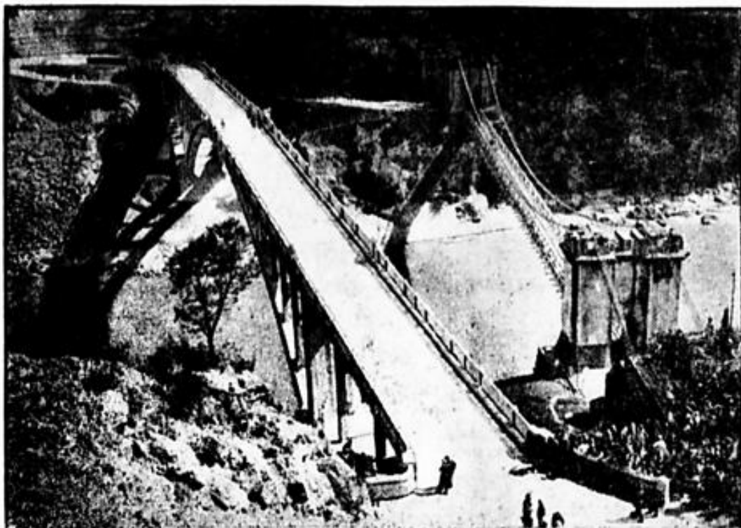
Die neue Brücke von Indien nach Tibet. Über das Teesta-Tal in Indien wurde an Stelle der alten Hängebrücke (rechts) eine moderne Bogenbrücke (links) gebaut. Die Brücke liegt im Zuge der Landstraße, die Indien mit Tibet verbindet.
