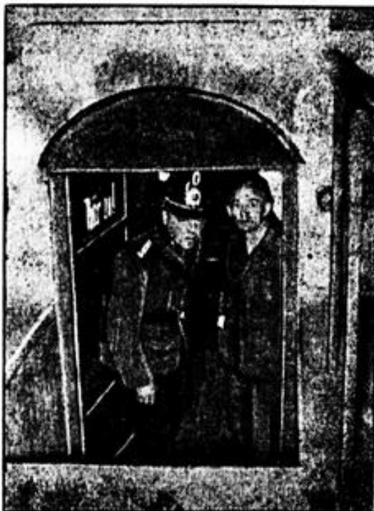
Reichstag-Tunnel wird besichtigt.
