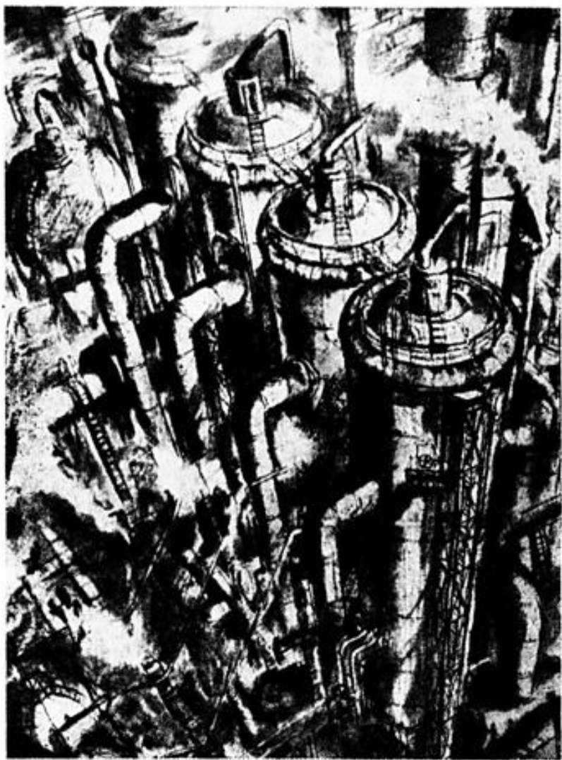
Blick auf eine Hochofenanlage
