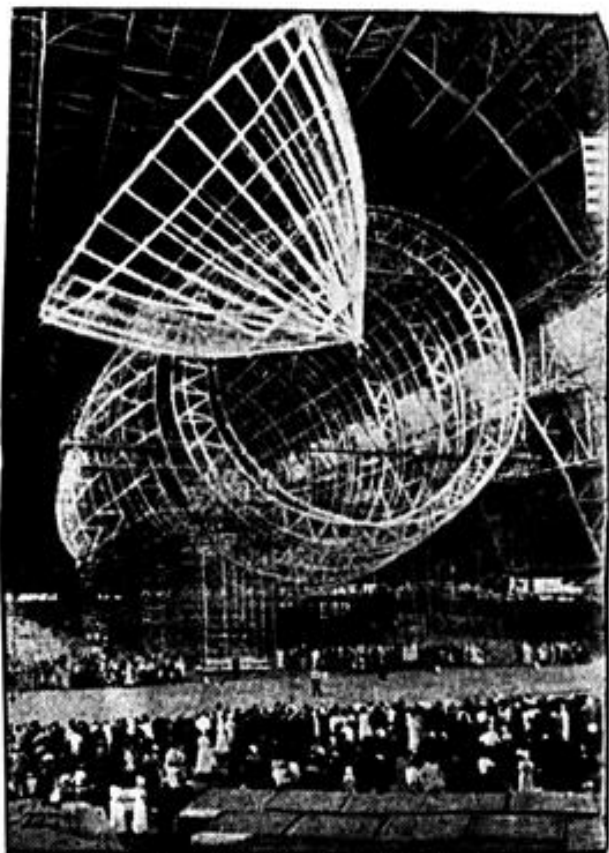
Die Luftschiffspitze wird montiert.
