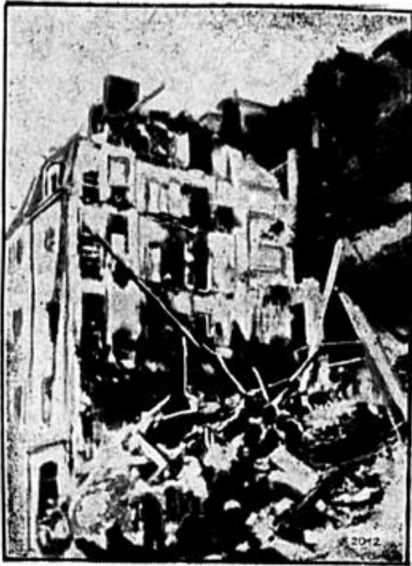
Bildtelegramm von der Lyoner Katastrophe. Infolge eines Erdbebens sind in Lyon zwei mehrstöckige Häuser vollständig eingestürzt. Etwa 27 Menschen fanden dabei den Tod.
