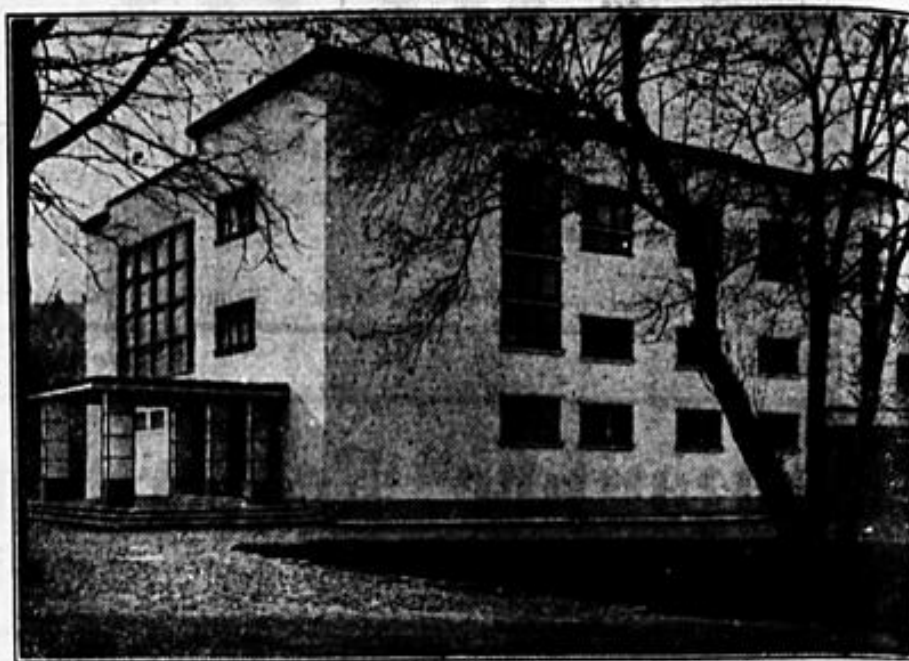
Gesamtansicht des neuen Sendehauses des Südwestdeutschen Rundfunks in Frankfurt a. M.
