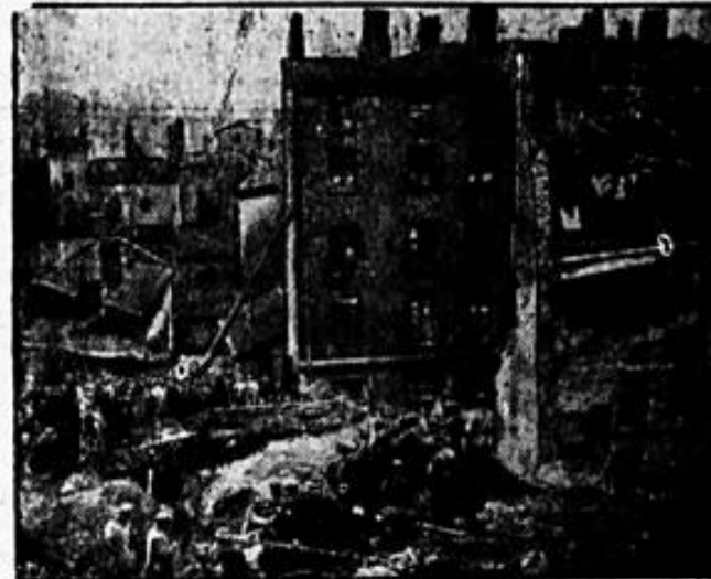
Aufräumarbeiten in Lyon.
