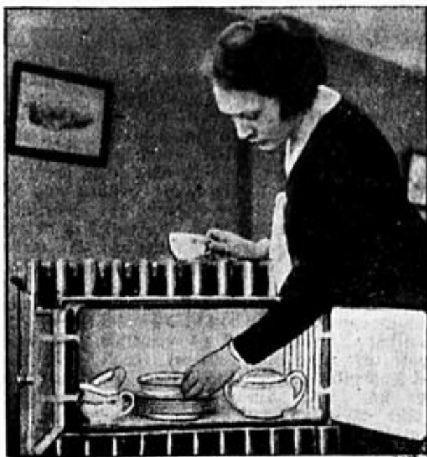
Wärmeschrank in der Zentralheizung.
