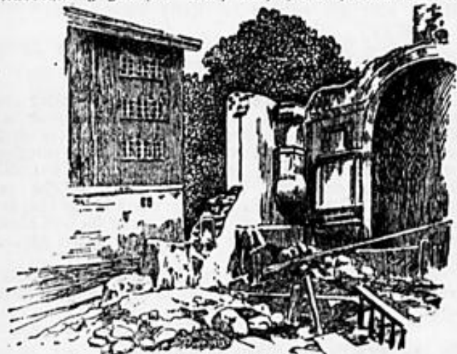
Die zerstörte Kirche von Ringgenberg
