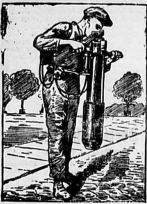
Eine neue Kamme für Straßenpflasterer.
