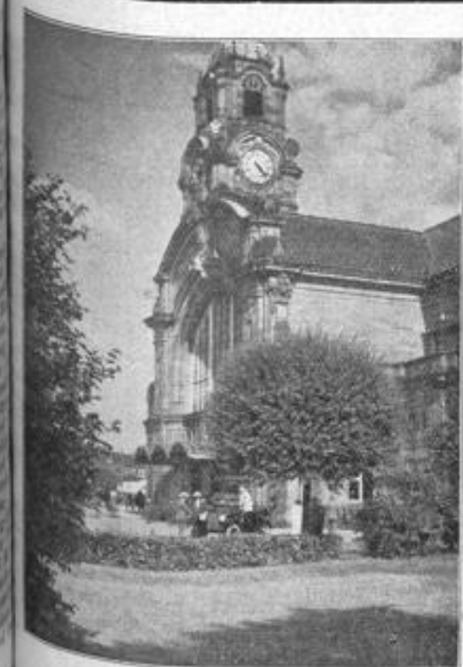
Blick auf das Bahnhofportal.
