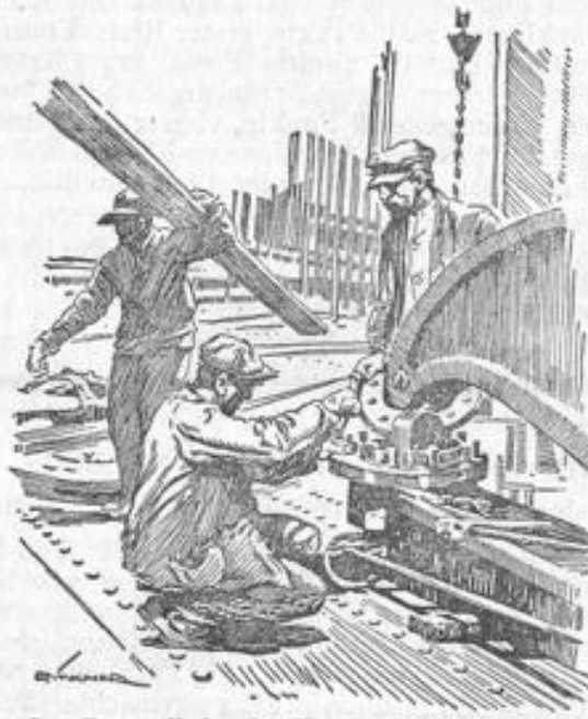
Der Presszylinder der Nietzange wird geprüft.
