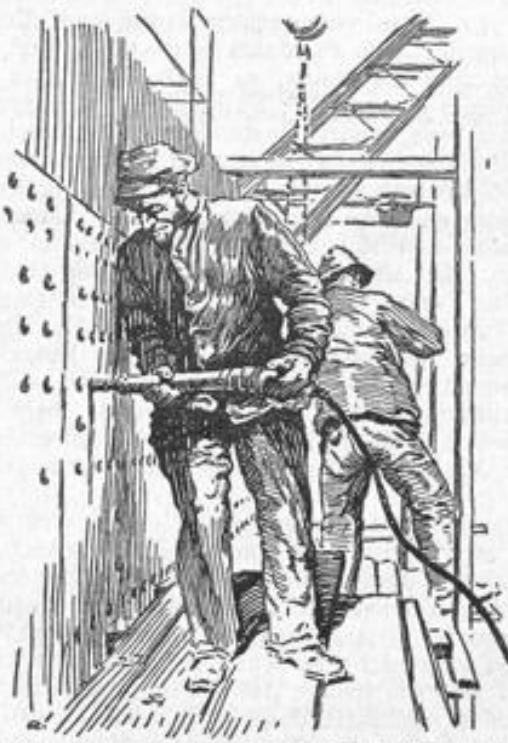
Nieten an der Aussenhaut mit Presslufthammern.
