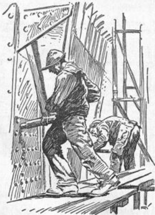
Der Vorhalter der Nietkolonne im Innern des Schiffes bei der Nietung der Aussenhaut.
